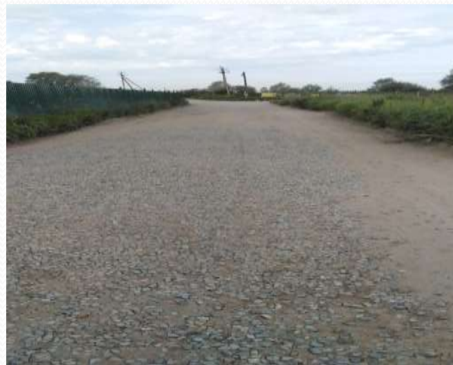
1-я Центральная (в районе кв.16-21 (после ремонта)
