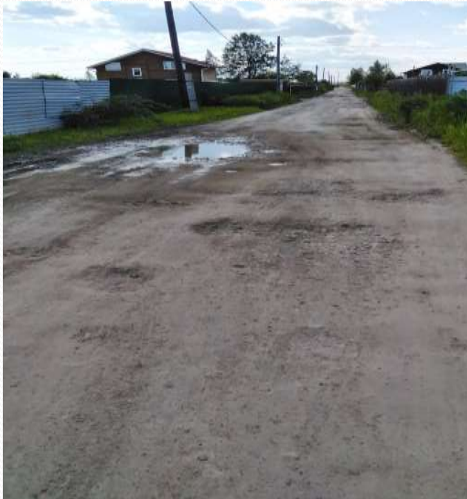
2-я Центральная (в районе кв.29-34 (до ремонта)
