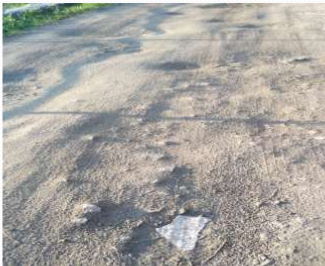
1-я Центральная (в районе кв.16-21 (до ремонта)
