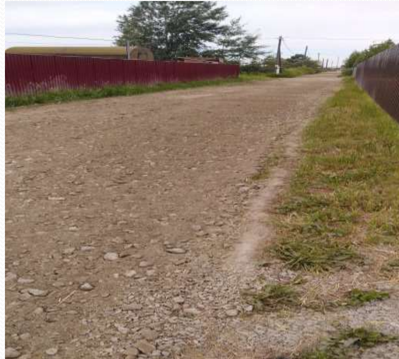
2-я Центральная (в районе кв.29-34 (после ремонта)
