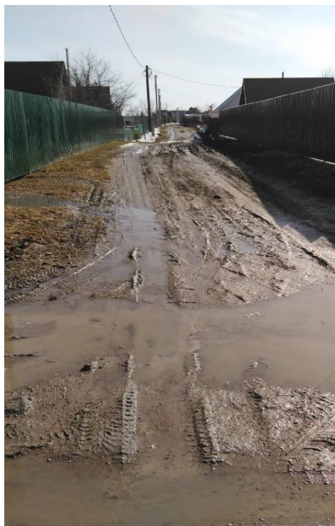
улица ЛУГОВАЯ КВ.23-24 до ремонта
